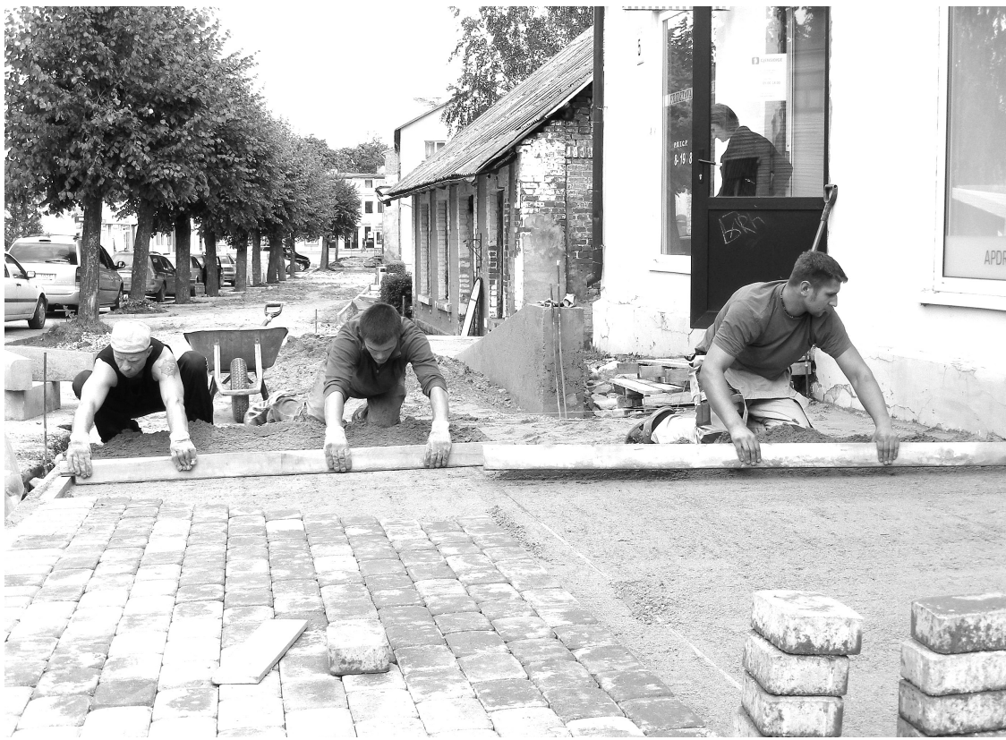
SIA "ZDZ" šonedēļ turpināja bruģēt ietvi Lielā Ezera ielā, jauns segums jau ir ietvei Tīrgotāju ielas posmā no Dārza ielas līdz Lielā Ezera ielai
